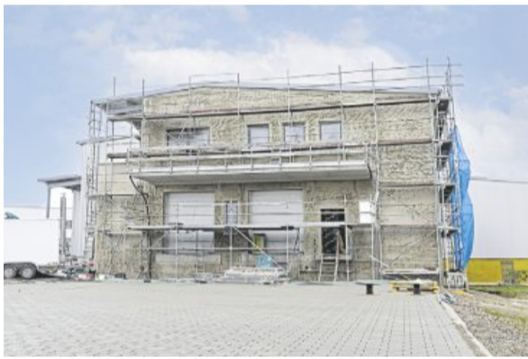
SPRiNTUS baut aktuell im Gewerbegebiet Schwabäcker ein neues Montage- und Logistikzentrum.
