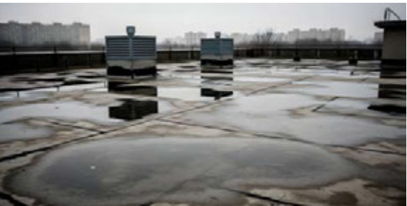
Rénovation de toit plat
